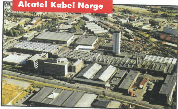
Hovedkontoret til Alcatel på Økern i Oslo.
